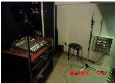
ステージ下手の設備(アンプ、ミキサー、マイク→ミキサーへの接続ジャック)
