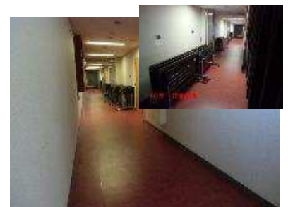
東側通路の北端から2号ホール方向
