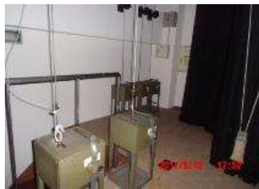
ステージ下手の設備(アンプ、ミキサー、マイク→ミキサーへの接続ジャック)ステージ上手の設備(バトンの上げ下げ装置)
