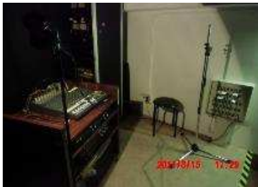
ステージ下手の設備(アンプ、ミキサー、マイク→ミキサーへの接続ジャック)ステージ上手の設備(バトンの上げ下げ装置)
