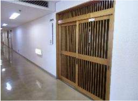
出入口の引き戸
