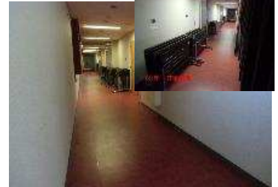
東側通路の北端から2号ホール方向
